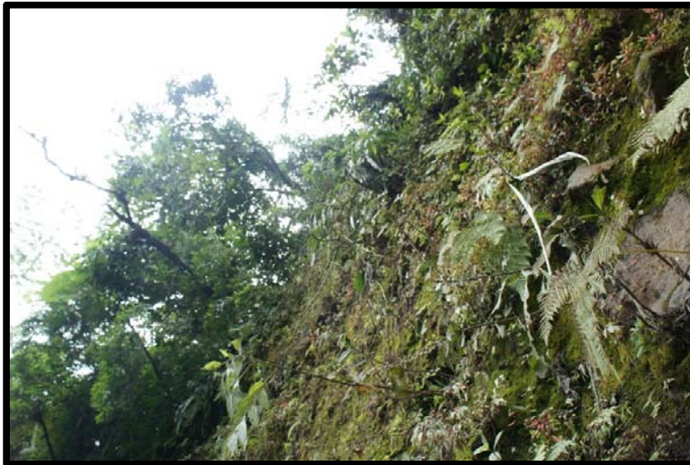
Fotografía No. 14 Pared lateral de la hondonada
