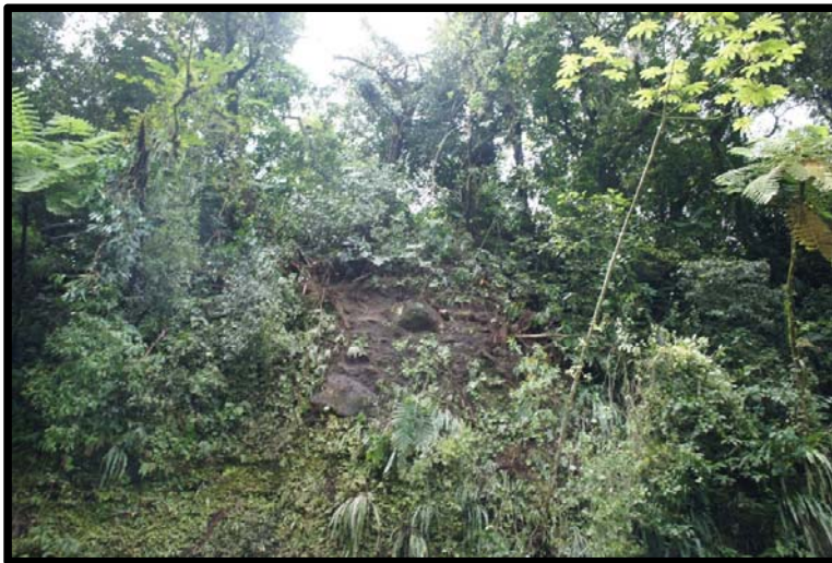
Fotografía No.12 Deslizamiento hacia abajo.
